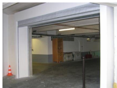
Parking rue de la Cavalerie - Paris 15è
